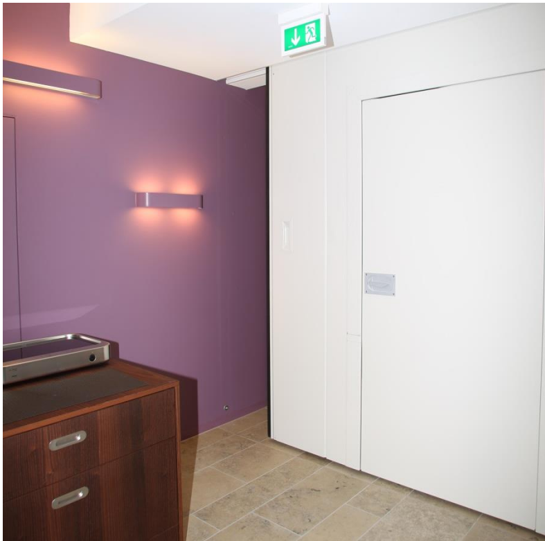
Bild 9: Stumpf einlaufende Feuerschutz-Schiebetore ermöglichen Durchgänge ohne Einschränkung bis 4500 mm.
