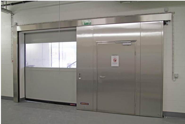
Bild 12: Edelstahl ist neutral im Kontakt mit Lebensmitteln und übersteht häufige und intensive Reinigungen im Lebensmittelbereich
