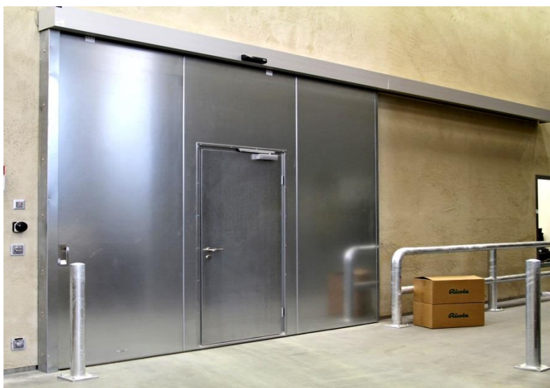
Bild 10: Schnelllaufendes EI 230 Feuerschutz-Schiebetor.
